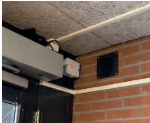
Centrale geluidskast (dicht). Geluid wordt via buizen met een diameter van 10 cm naar roosters in te dekken ruimtes geleid.
