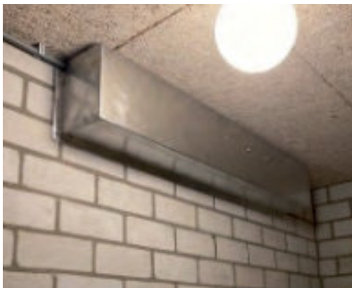
Centrale geluidskast (dicht). Geluid wordt via buizen met een diameter van 10 cm naar roosters in te dekken ruimtes geleid.
